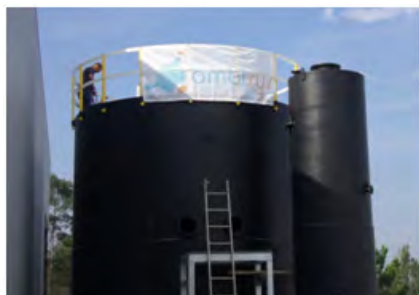
Figures 1 Reator SLS – Instalação Piloto testada na Lipor em 2011. Co-digestão da fração orgânica dos resíduos sólidos municipais com lamas de ETAR. SLS reactor – Pilot plant installed at Lipor (2011). Co-digestion of the organic fraction of municipal solid waste and FOG (fat oil and grease) sludge.
